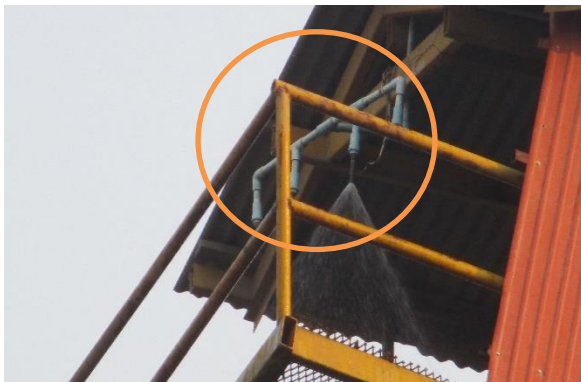
รูปที่ 2-12 ระบบสเปรย์น้ำของโครงการ
