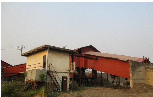
รูปที่ 2-9 การปิดปกคลุมโรงโม่หิน
